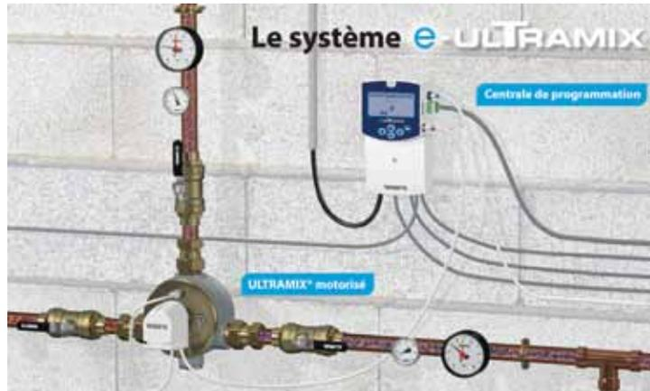
Pour un véritable suivi sanitaire de l'installation, la centrale de programmation enregistre tous les paramètres relatifs au processus de désinfection (température, durée...) ainsi que les diverses signalisations et alarmes relevées. L'ensemble des données est stocké sur la carte micro-SD intégrée à la centrale afin de pouvoir récupérer à tout moment l'historique sur un an, et l'exploiter sur un ordinateur au format CSV.
